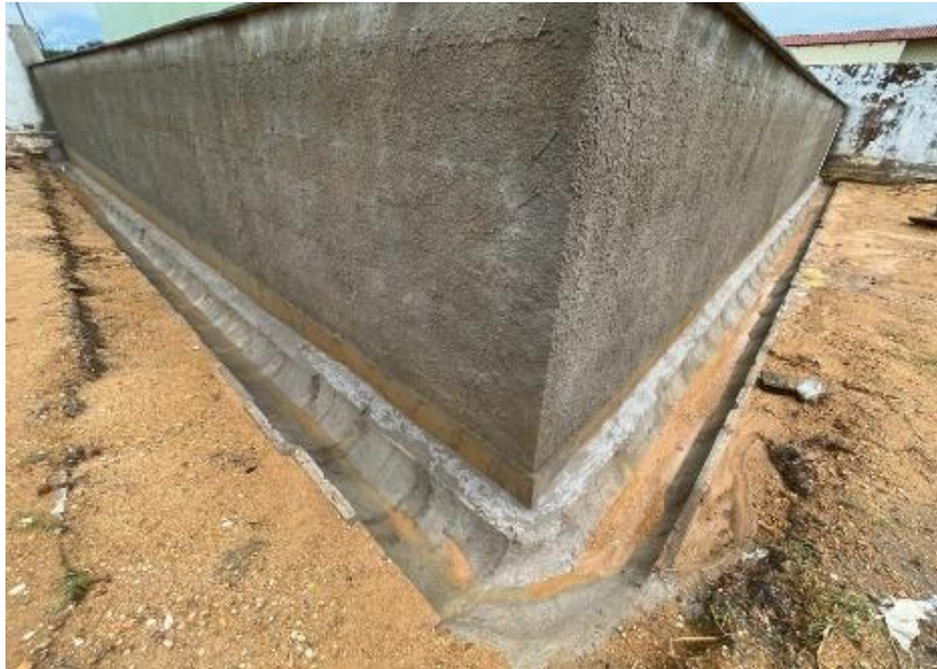
Imagem 05: canaleta de drenagem pré-moldada;
